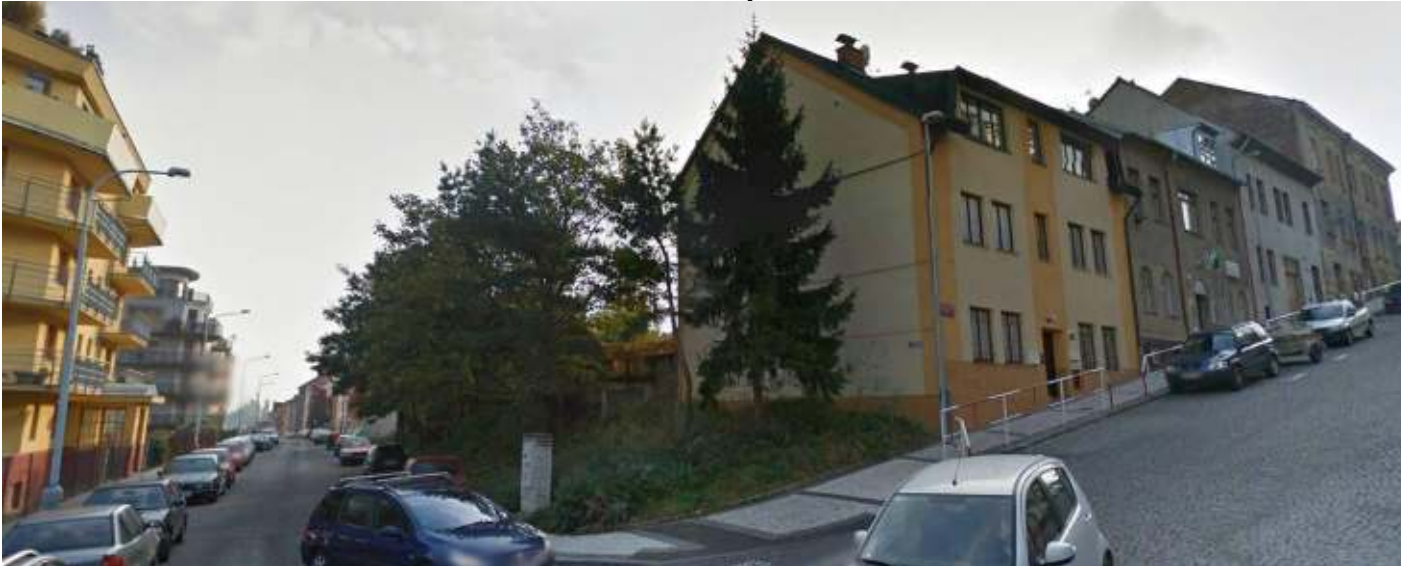
obr. foto Google street - nároží Šlikovy a Kocmanovy a č.p.369
