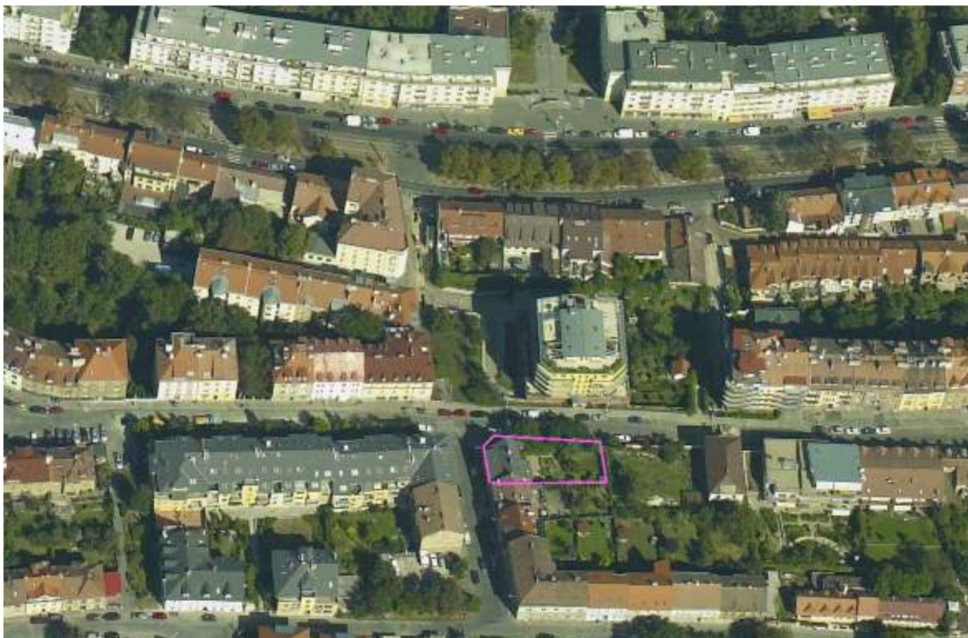
obr. letecké foto od jihu – lokalita s řešeným pozemkem
