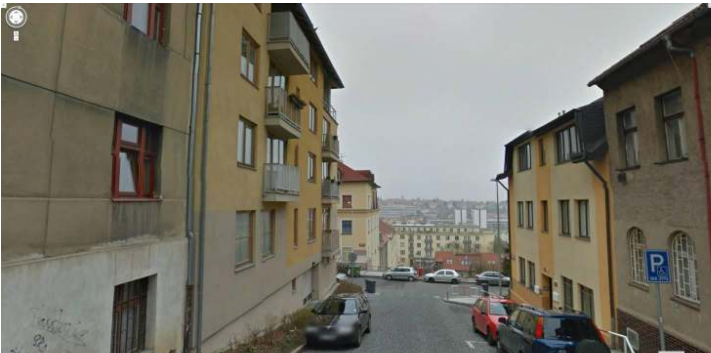
obr. foto Google street – pohled z Kocmanovy směrem ke křižovatce – stávající čp. 369 vpravo
