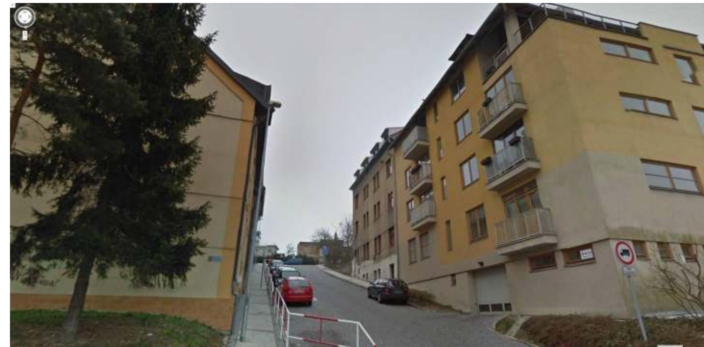
obr. foto Google street – rozdíl objemů, úrovně průčelí a výšek na nárožích
