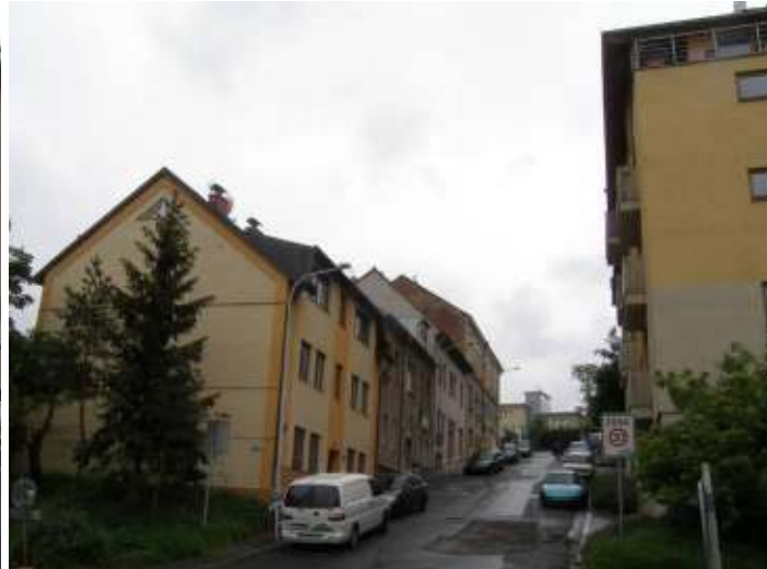
foto rozdíl výšek a úrovně na křižovatce
